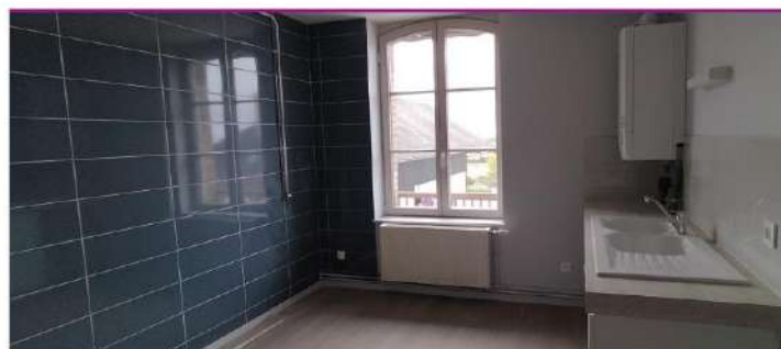
Rénovation énergétique : logement à Herbigny.
