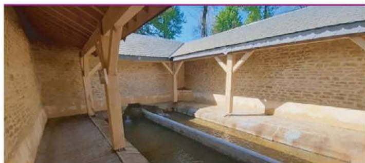
Chantier du patrimoine : Lavoir de Boulzicourt.
