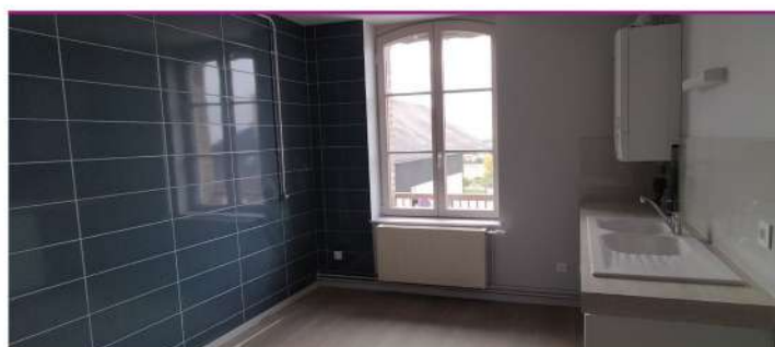
Rénovation énergétique : logement à Herbigny.
