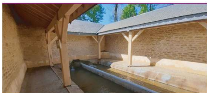
Chantier du patrimoine : Lavoir de Boulzicourt.
