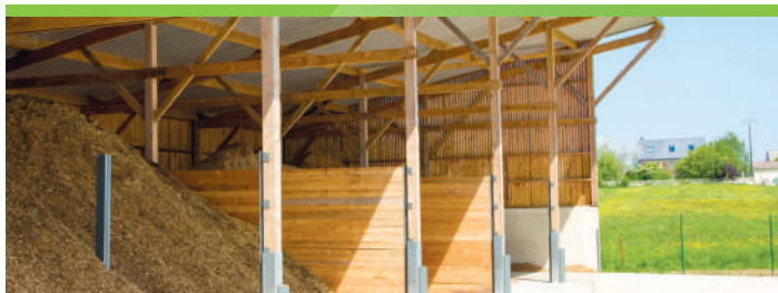
Plateforme bois à Faissault
