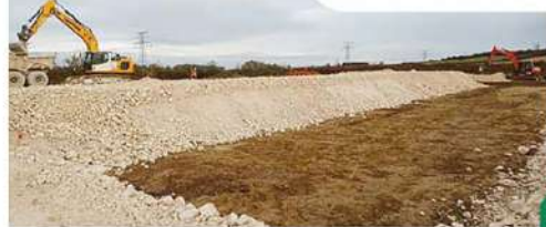
Station d'épuration - Lucquy et Coucy
