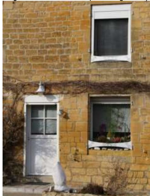
**Sont autorisés :** Volets roulant avec rails en retrait et de la couleur de la menuiserie et coffre dans l'épaisseur du mur.
