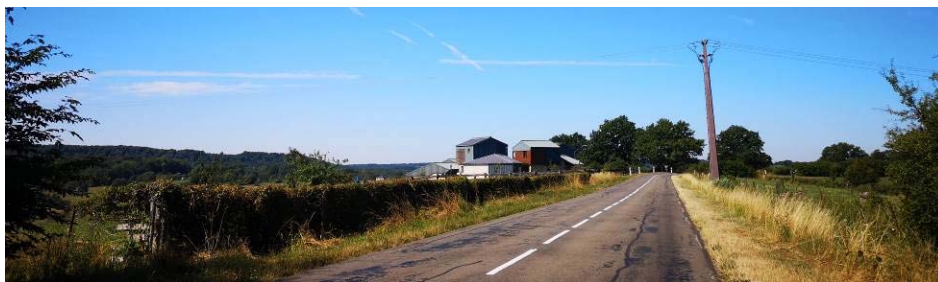
Vue depuis la route de Thin et le site à gauche de la RD (© Photographies BE Dumay)
