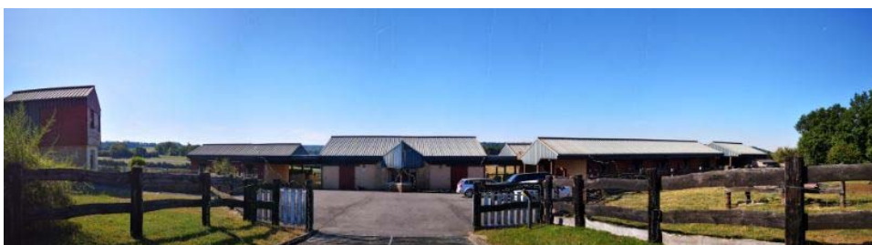
Vue sur l'entrée du site existant (© Photographies BE Dumay)
