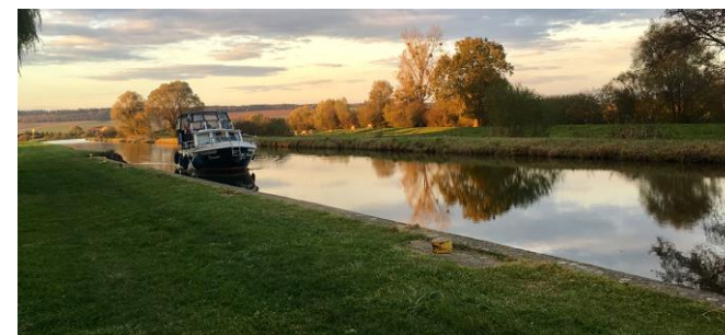
Aménagement future Voie Verte Sud Ardennes
