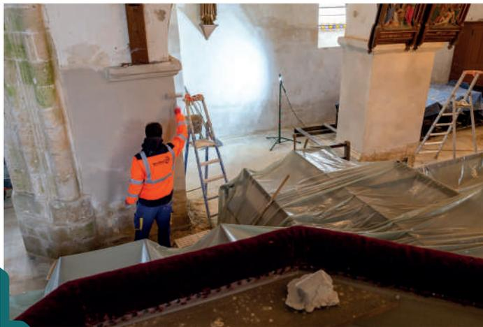
La majorité du chantier visait à rénover les murs et les colonnes de la nef, qui se dégradait à vue d'œil. « La pierre était fortement endommagée, il y avait de grosses réparations de maçonnerie », explique Eric Sagonero, encadrant du chantier d'insertion travaux chez API.
