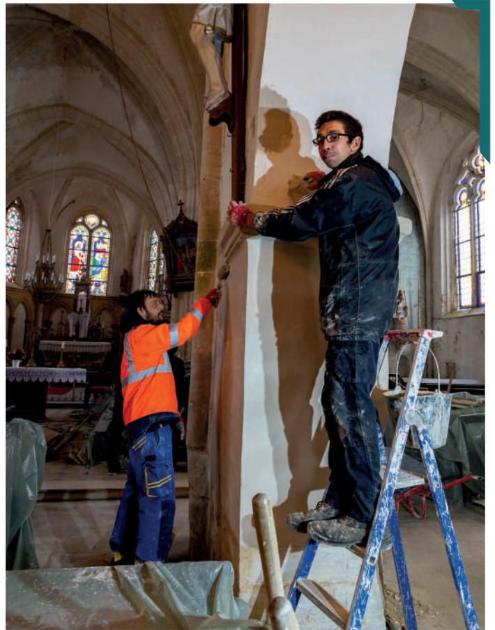
Les travaux se sont faits dans « le respect de la tradition » pour conserver le style original de l'église. Après démontage et nettoyage des parties endommagées, tous les murs ont été rénovés avec un enduit traditionnel à la chaux.
